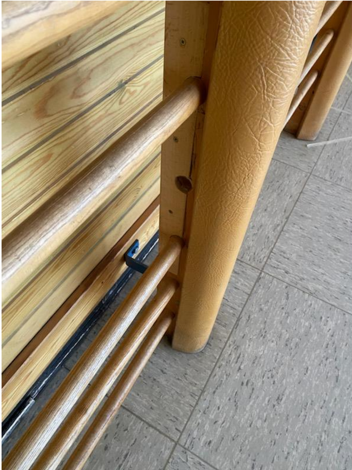
Detail Fußpunkt mit Befestigung sowie Anprallschutz an der Sprossenwand
